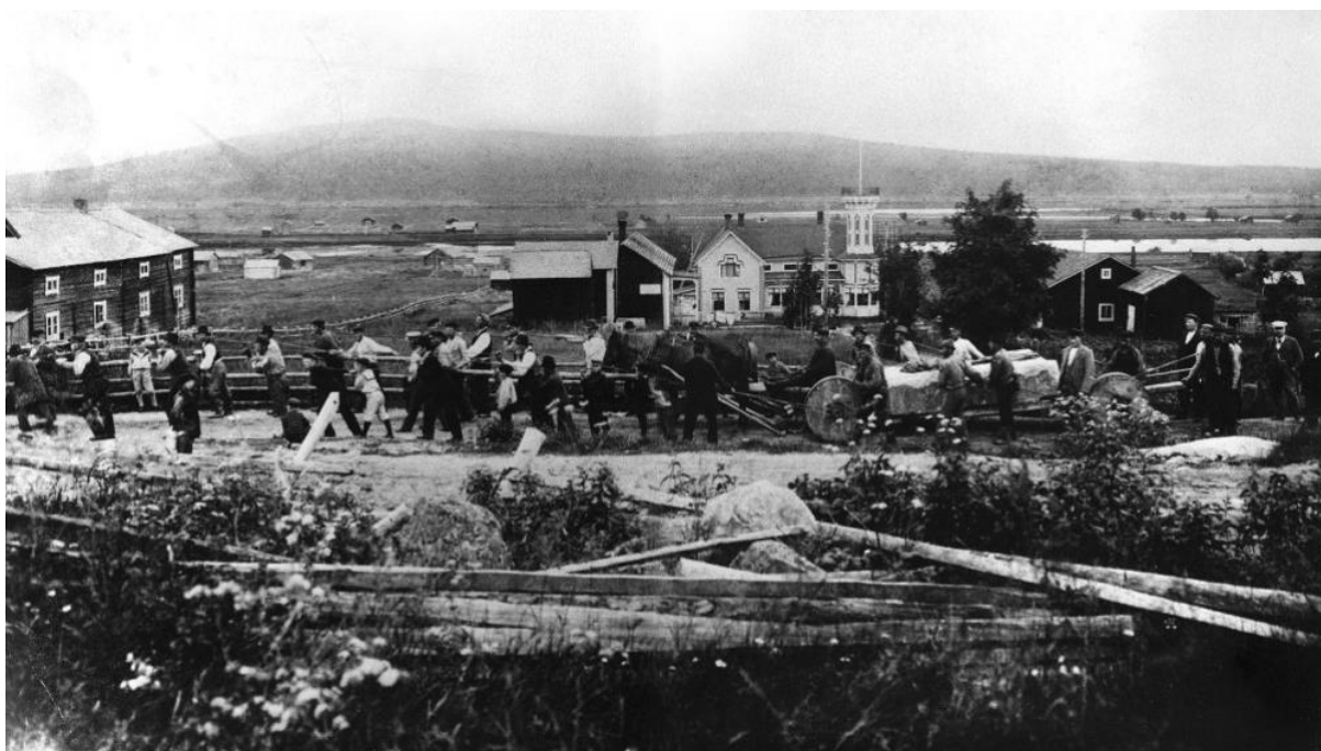
Mina Plantings fotografi av transport av sten till kyrktrappan i samband med renoveringen av Övertorneå kyrka 1902/1903. Mannen i vita skärmöissan längst till höger är länsman Magnus Ström. NKFC:s bildarkiv
